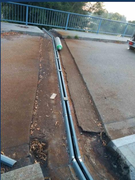
**Arbeitsumfang:** einseitiger Austausch des unterstromigen Geländers, Erneuerung Übergang beim Wiederlager, Kapfenbeschichtung Gehweg abschleifen
