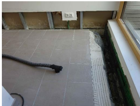
Der geöffnete Fußboden
