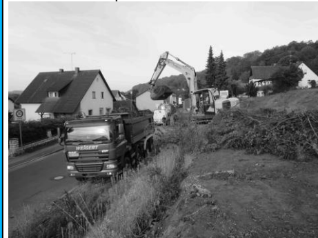
Beginn der Bauarbeiten 2.9.
